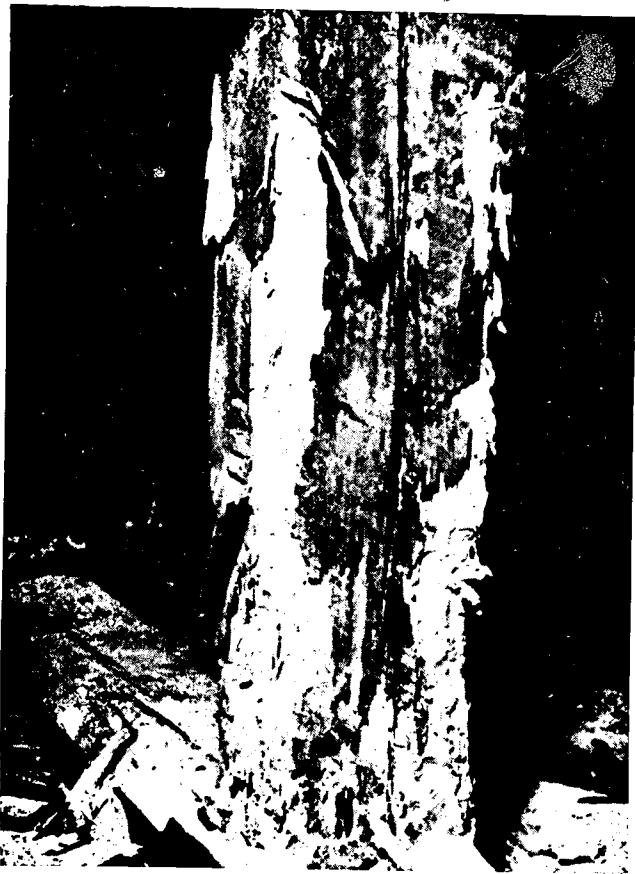
Močno poškodovan drog
