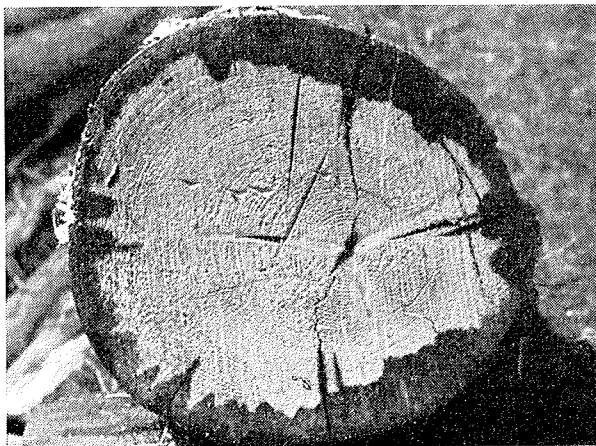
Sl. 1. Prečni prerez smrekovega, s katranskim oljem impregniranega električnega droga. Na prerezu se vidi, kako globoko je difundiralo katransko olje. Električni drog je bil v 35 kV daljnovodu Ptuj—Ljutomer—Murska Sobota
